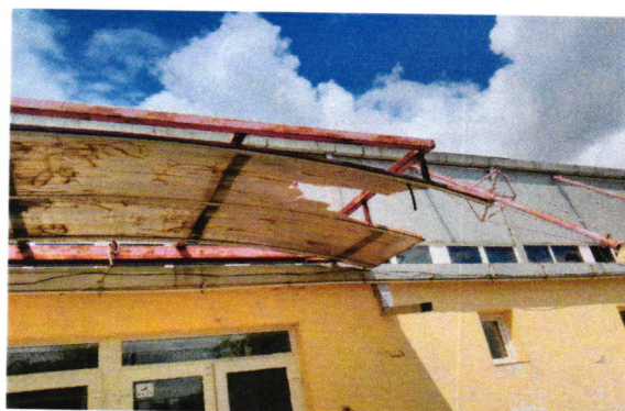
Foto copertina intrare si corp secundar vestiare – Invelitoarea copertinei este degradata , iar structură metalica necesită protecție anticorozivă urgentă . De asemenea, conform expertizei tehnice lemnul șarpantei ce susține învelitoarea trebuie tratat antiseptic si ignifug după înlocuirea tuturor elementelor degradate .
