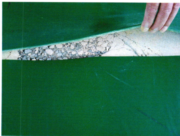
Foto strat suport suprafață de joc corp principal Sală de sport – In urma exploatării stratul suport al suprafeței de joc a cedat fiind necesară înlocuirea pentru a asigura siguranța în exploatare
