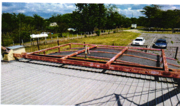
Foto copertina intrare si corp secundar vestiare – Invelitoarea copertinei este degradata , iar structură metalica necesită protecție anticorozivă urgentă . De asemenea, conform expertizei tehnice lemnul șarpantei ce susține învelitoarea trebuie tratat antiseptic si ignifug după înlocuirea tuturor elementelor degradate .
