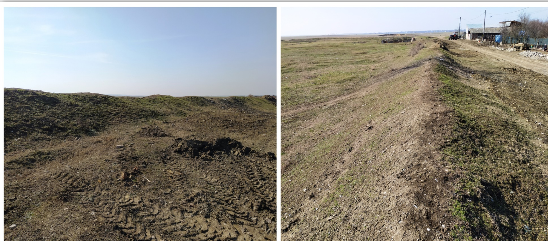
Foto: Dig de protectie, Căzănești; Sursa:-Imagini puse la dispozitie de Primarie
