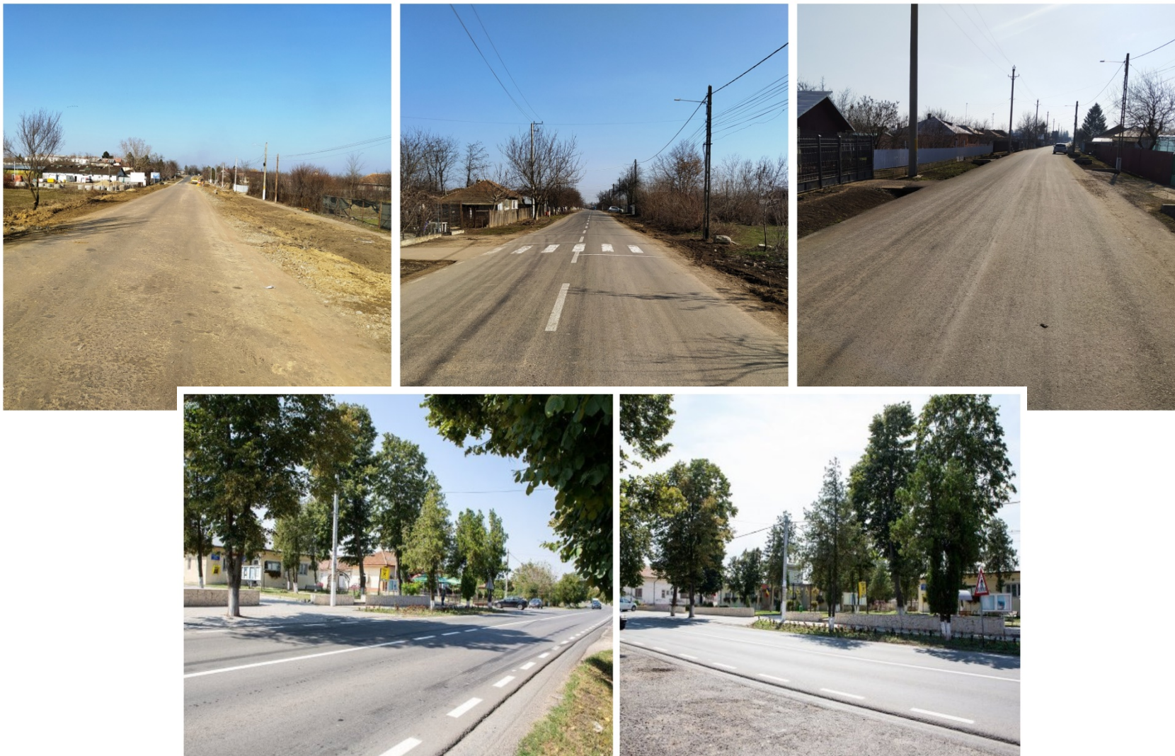
Foto: Drumuri orașene in Căzănești( Str. Garii, Str. Nordului, Str. Dispensarului si Str. Bucuresti) -Sursa: Imagini puse la dispozitie de primarie
